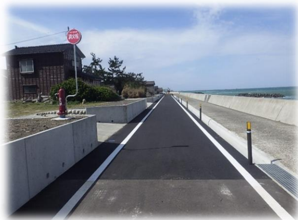
新設された市道大和川海浜線
